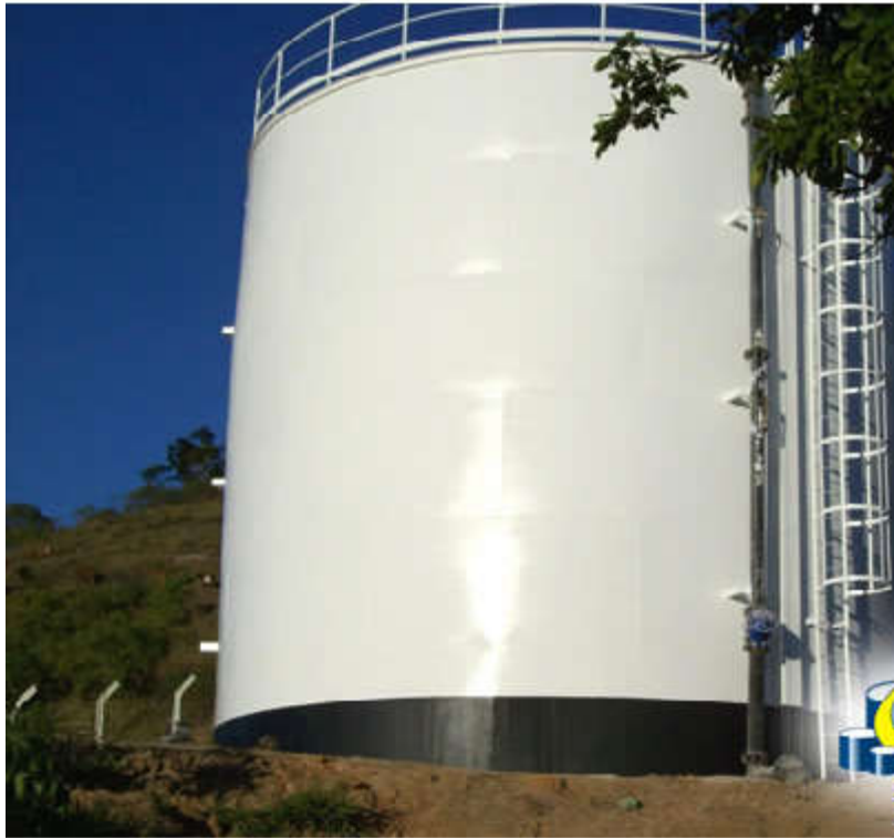
Reservatório Vertical Apoiado
